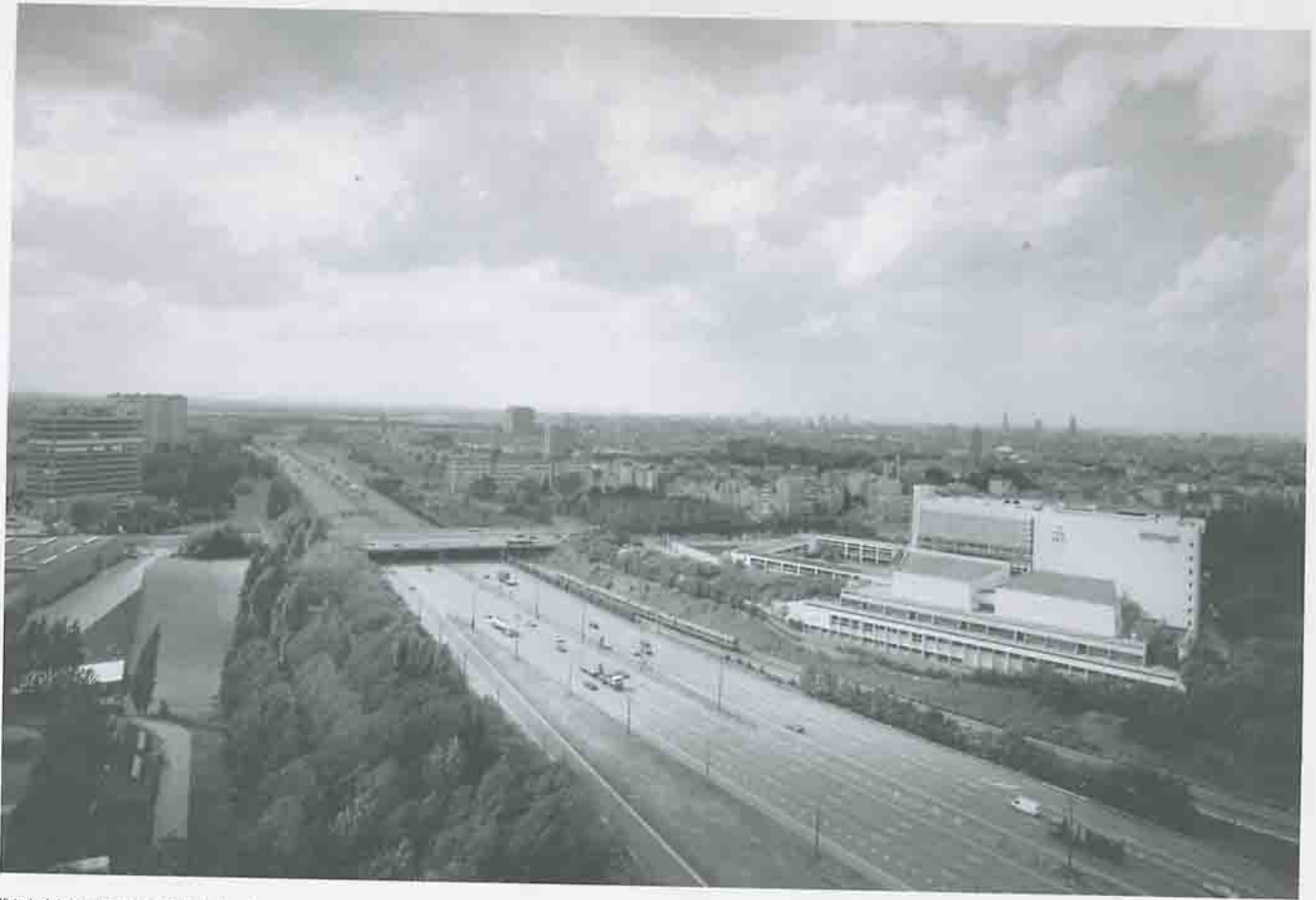
Vista desde la autovía de circulación / View from freeway
